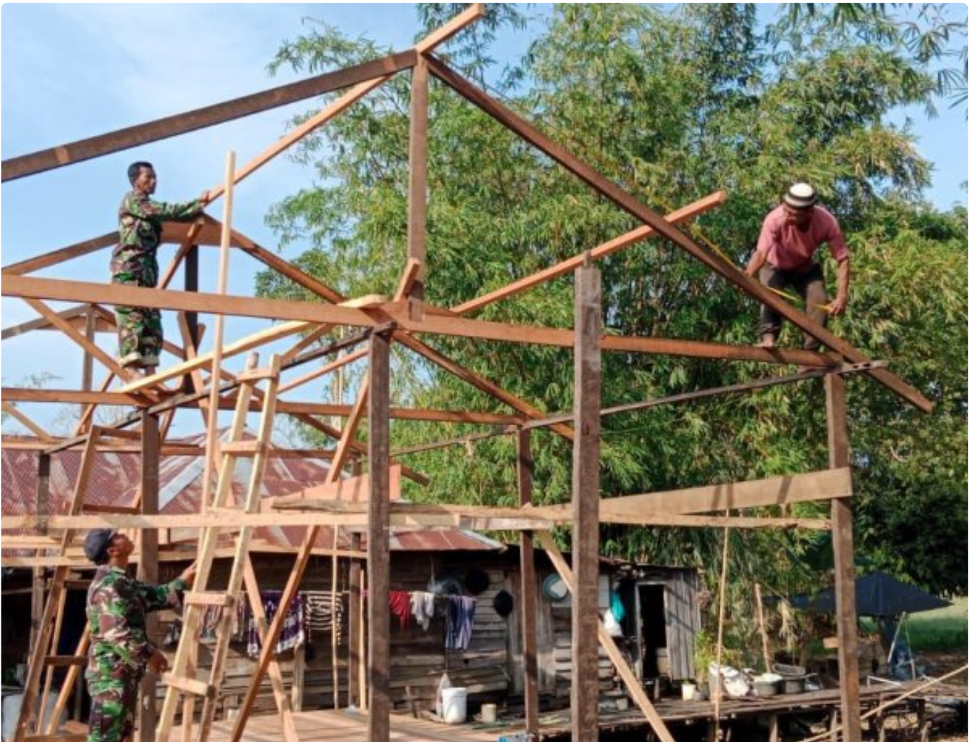
Karya Bakti TNI " Kodim 1006/Bjr Rehab Rumah Kini Sudah Pemasangan Lantai Dan Kuda - Kuda
